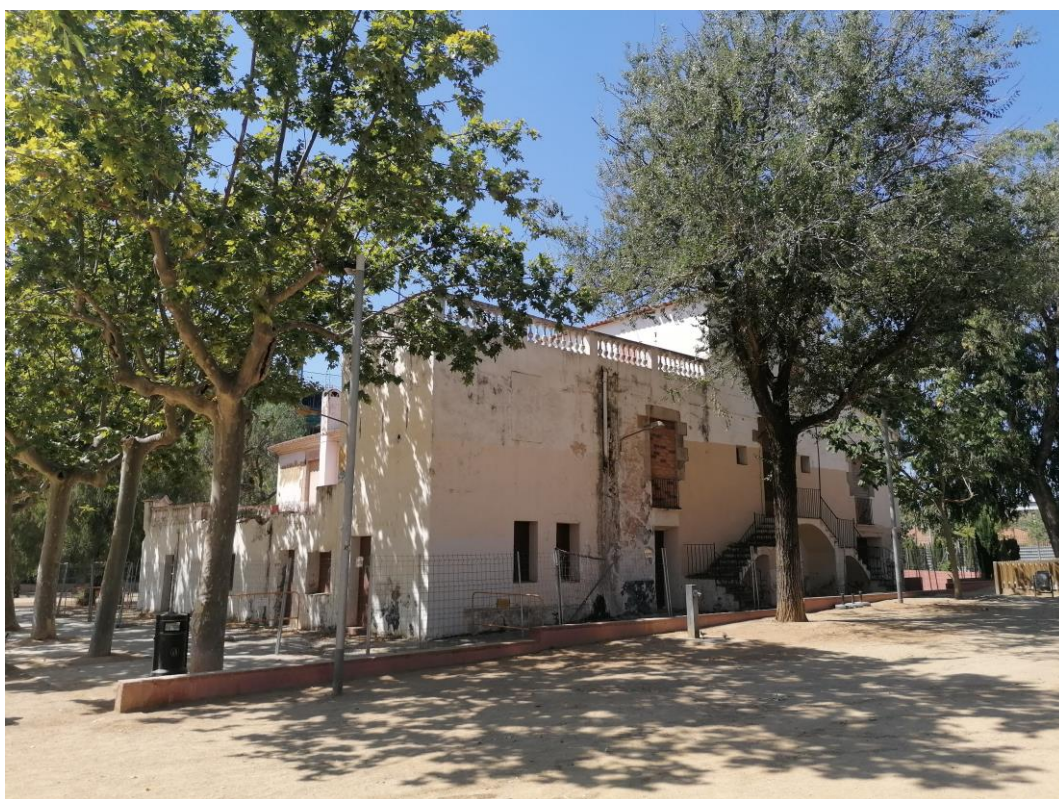
Façanes est i nord (juliol de 2022)
