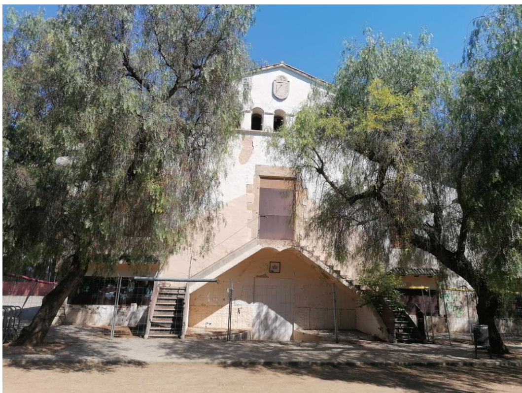
Façanes sud (juliol de 2022)
